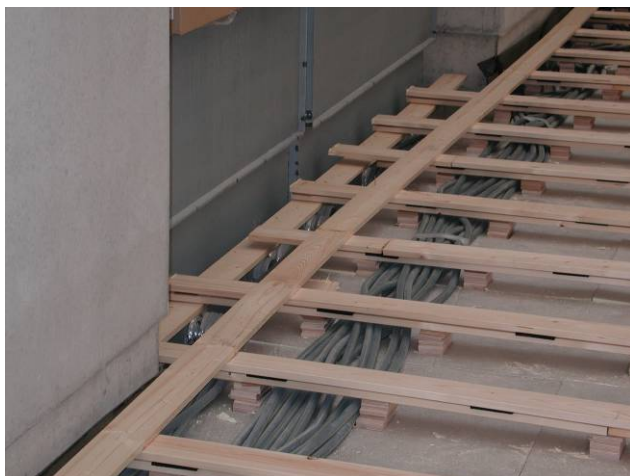
Ajustage à des tubes électriques
