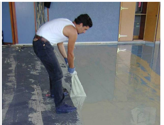
Erreurs de mélange ; le polyuréthane a seulement partiellement polymérisé et doit être enlevé
