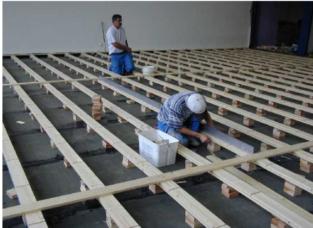
Egalisation à niveau avec des plots en bois dur (brique etc...) comme support pour les lambourdes
