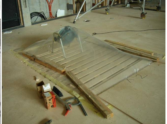
Assèchement de la sous construction
