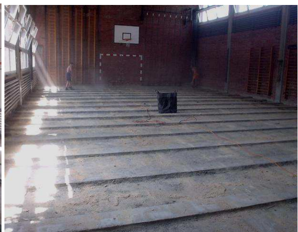
Après la dépose d'anciens sols, découverte de conduites de chauffage pour le sous-sol et de divers renforcements pour la dalle qui devrait être le support pour les futurs sols sportifs.
