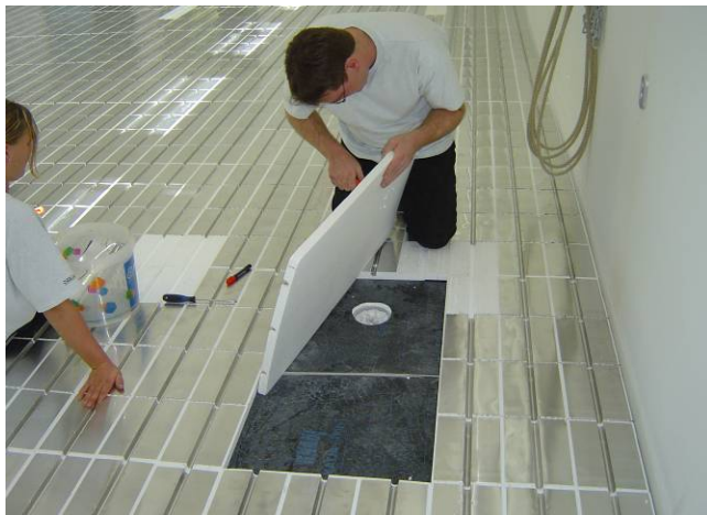
Pose de l'isolation adaptée au système, des panneaux de répartition de chaleur et des tuyaux
