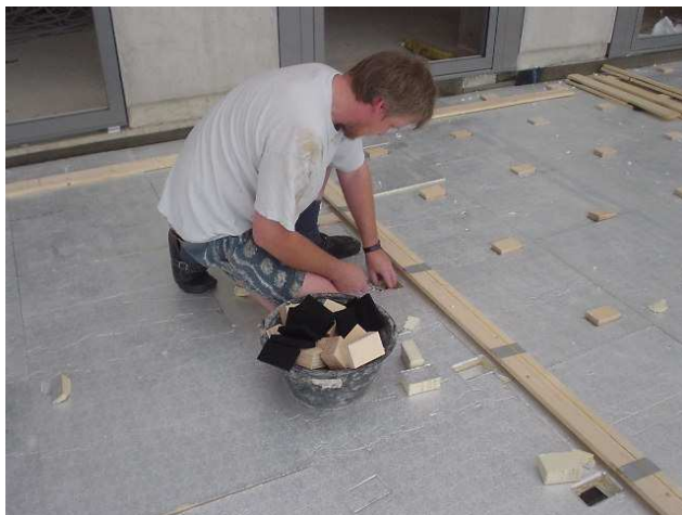
Découpe de l'isolation pour la pose de l'égalisation à niveau
