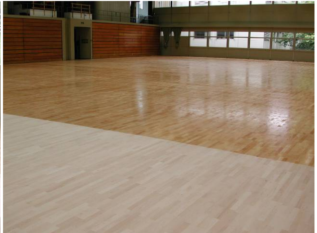
Ponçage fin de la surface et vernissage de la surface en trois couches, min 300gr. / m2 Attention : Il est recommandé d'appliquer le marquage après la première couche de vernis!
