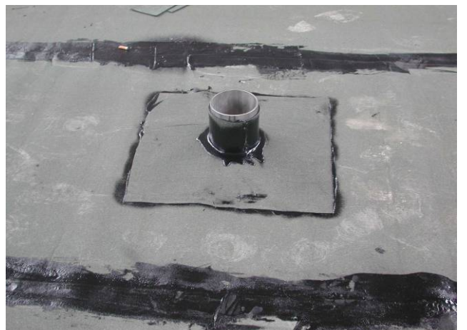
Remonté contre les murs, portes etc.. en pose flottante, par contre, remonté et collage contre les douilles
