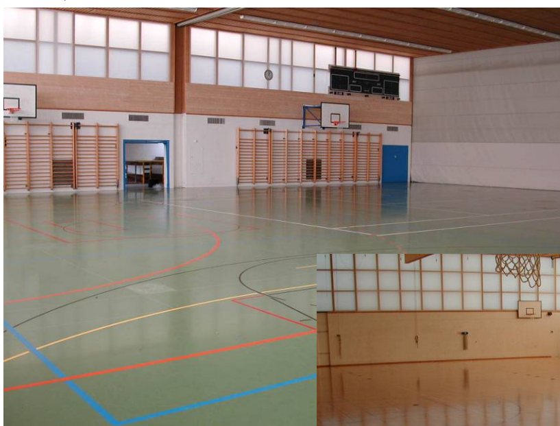
Sol compact à élasticité répartie en parquet, posé directement sur l'ancien sol en polyuréthane
