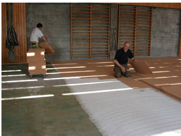
Pose de la sous-couche avec des éléments en lièges. Finition en PVC tendu, fixé aux bords de la salle ; ou Linoléum collé, les deux solutions avec des joints soudés.
