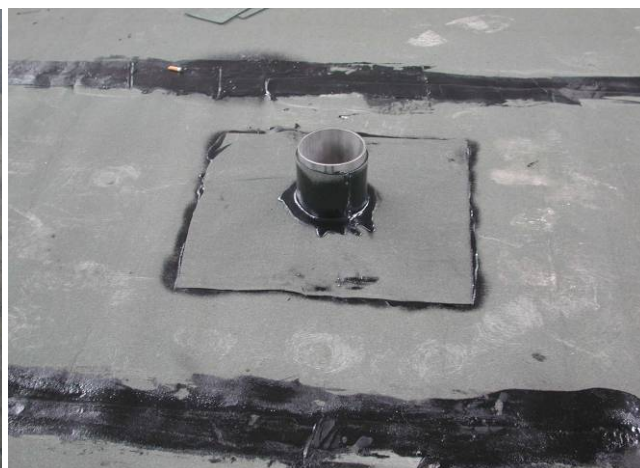
Remonté et collage de l'étanchéité
