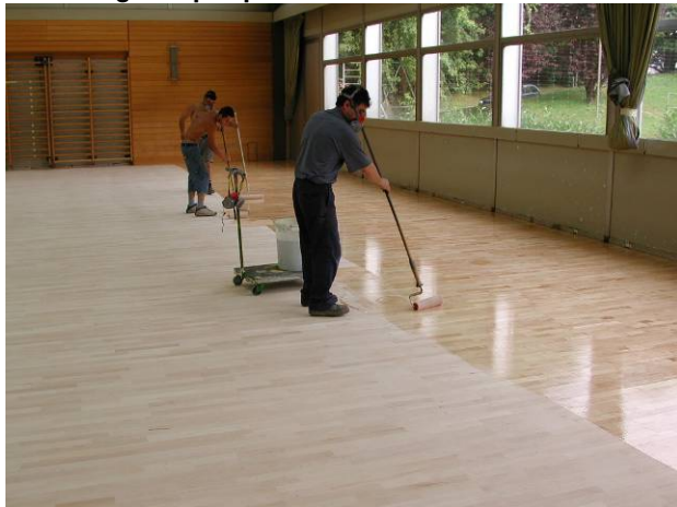
Ponçage fin de la surface et vernissage de la surface en trois couches, min 300gr. / m2 Attention : Il est recommandé d'appliquer le marquage après la première couche de vernis!
