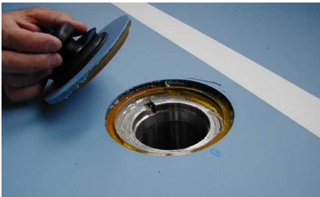
Couvercle trop mince, qui se déforme, esthétiquement pas beau et dangereux pour le sportif
