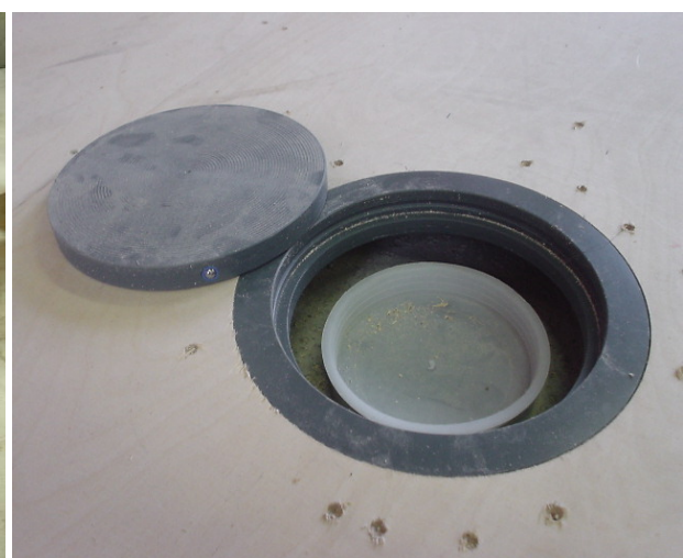
Finition avec un couvercle sans appui sur la douille et étanche à l'eau de nettoyage
