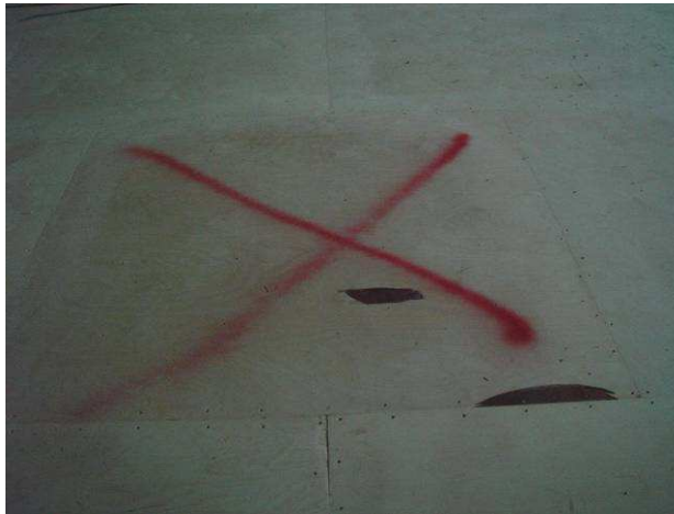
Remplacement des panneaux trop humides, et assèchement de la sous-construction
