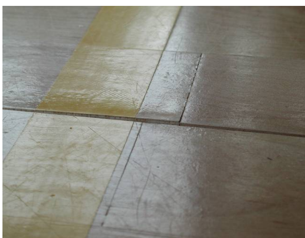
Délamination, ouverture des joints, rétrécissement etc...
