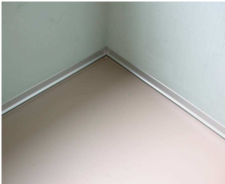
Variante avec coin en alu, plinthe supérieure en alu contre le mur et espace pour l'aération du sol
