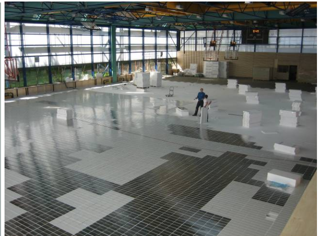
Pose de l'isolation adaptée au système, des panneaux de répartition de chaleur et des tuyaux
