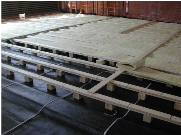
Isolation posée entre les lambourdes
