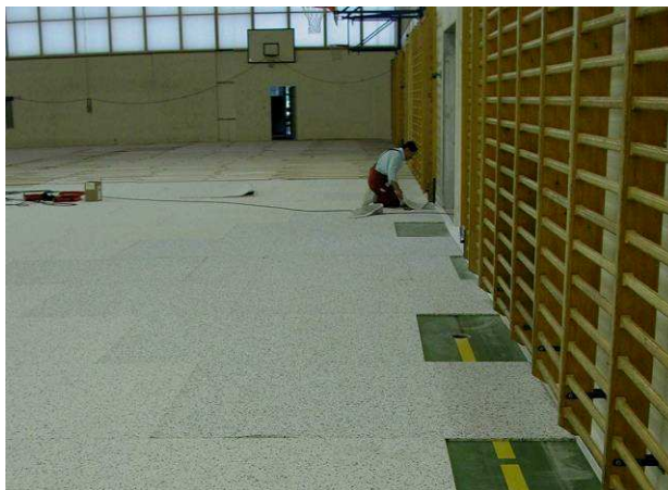
Lors d'une rénovation : pose du sol compact directement sur l'ancien sol sportif
