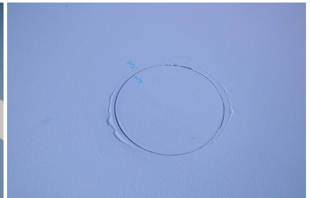
Couvercle trop mince, qui se déforme, esthétiquement pas beau et dangereux pour le sportif
