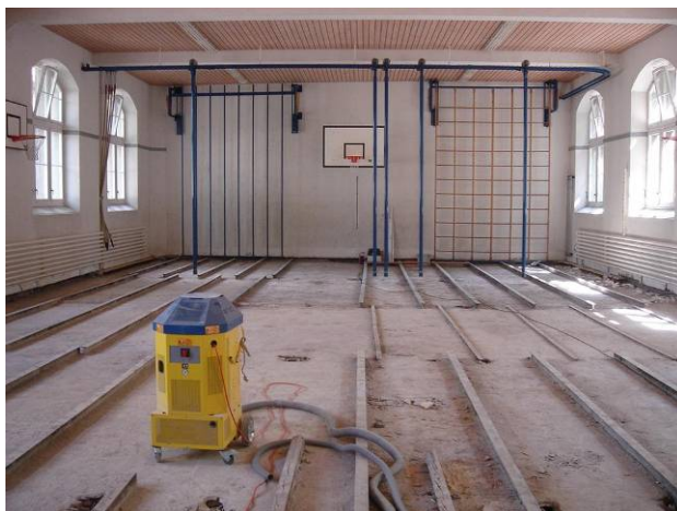
Après la dépose d'anciens sols, découverte de conduites de chauffage pour le sous-sol et de divers renforcements pour la dalle qui devrait être le support pour les futurs sols sportifs.
