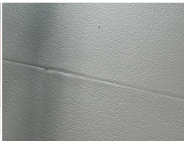
Pose de la sous-couche avec des éléments en lièges. Finition en PVC tendu, fixé aux bords de la salle ; ou Linoléum collé, les deux solutions avec des joints soudés.
