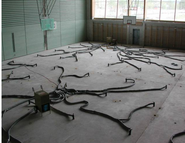
Assèchement de l'isolation sous la chape
