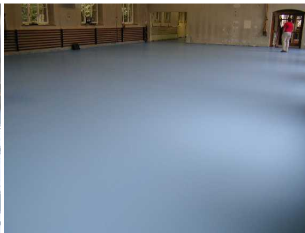
sol après le vernis mat, avant le marquage
