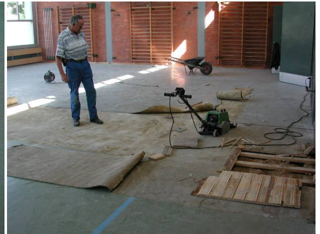
Remplacement des panneaux trop humides, et assèchement de la sous-construction
