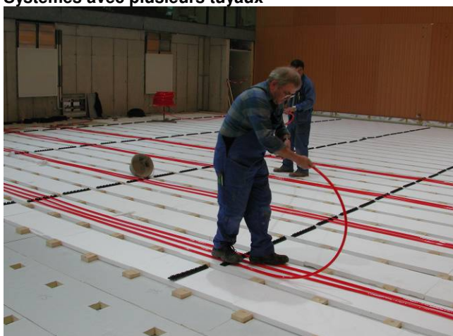
Pose des tuyaux du chauffage entre les lambourdes
