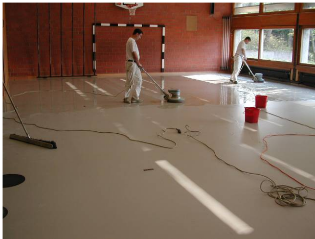
Application en surface d'une émulsion de protection
