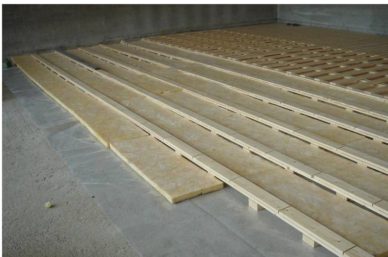
Triple lambourrage, isolation phonique et parquet
