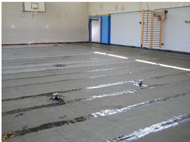
Lés en bitume avec des joints collés
