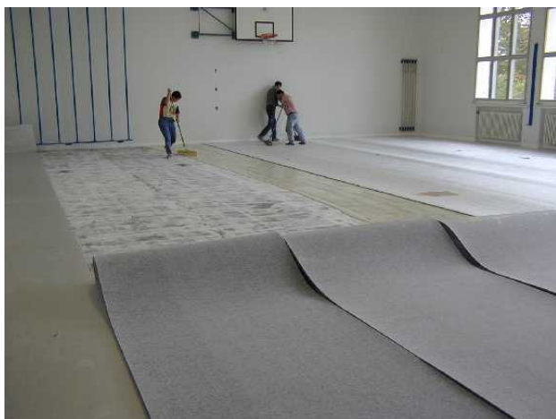
Pose des sous-couches élastiques
