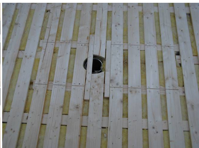
Renforcement du sol autour des douilles tout en restant souple (sans appui dur!)
