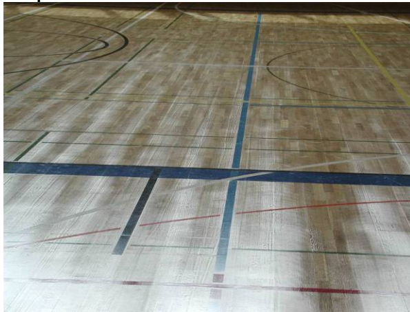
Distribution irrégulière du vernis avec des surépasseurs
