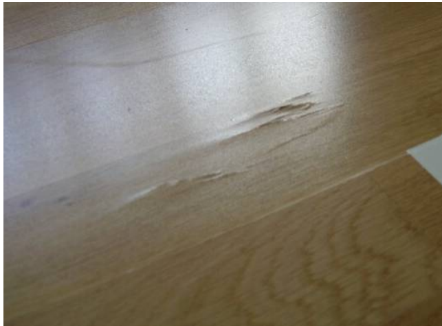
En cause : qualité et pose de parquet insuffisant
