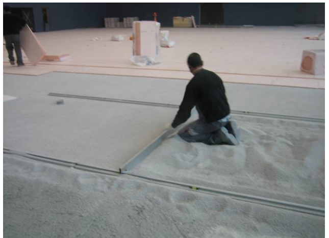
Egalisation du niveau avec des granulés bitumés, sable de quartz ou matériaux similaires
