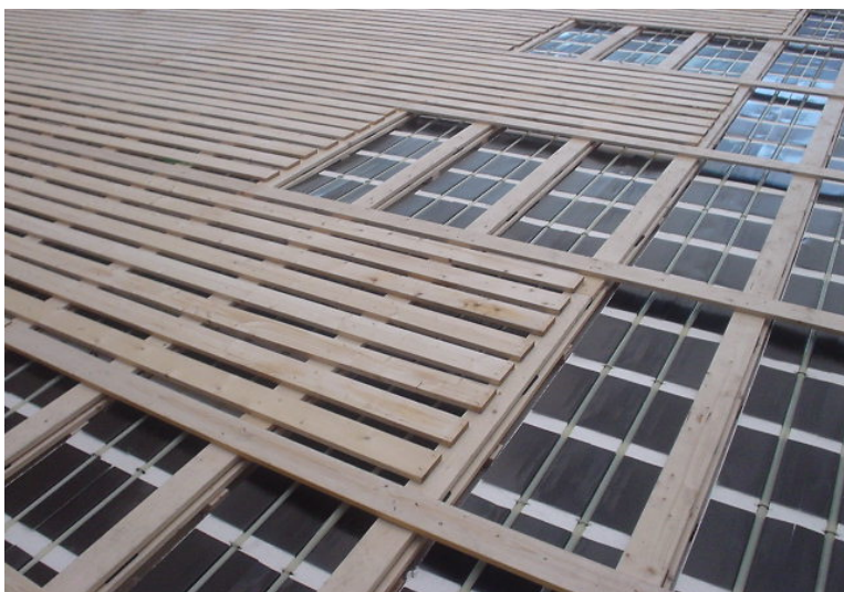
Triple lambourrage, chauffage au sol et polyuréthane
