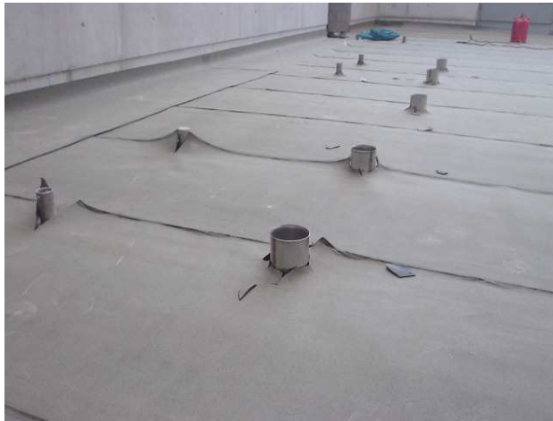
Pose des lés et leurs soudures
