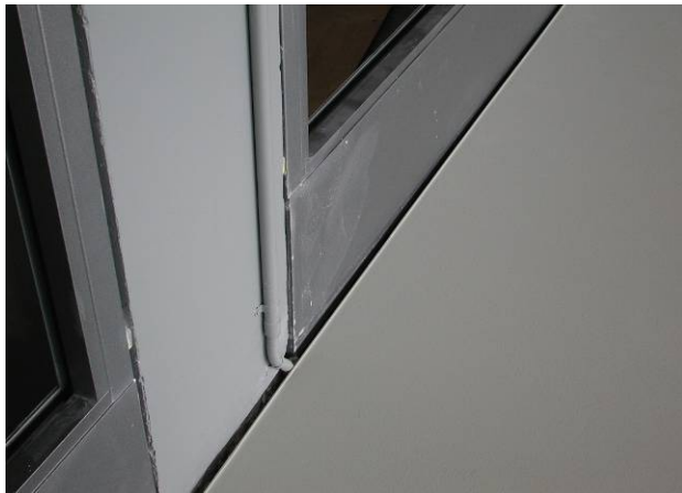
Finition sans plinthe, sol entouré avec un coin en alu
