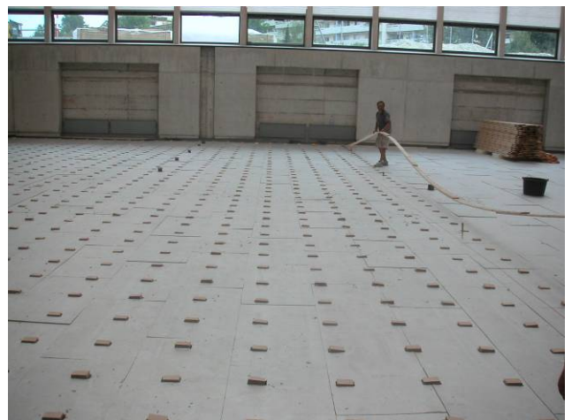
Egalisation à niveau avec des plots en bois dur (brique etc...) comme support pour les lambourdes
