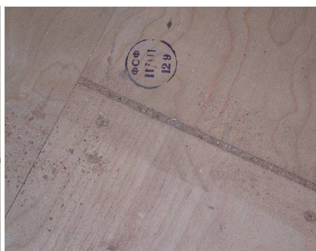
Fermeture des joints avec un mastic. En cas de changement de dimension (tension), il pourrait résulter des problèmes de garantie !
