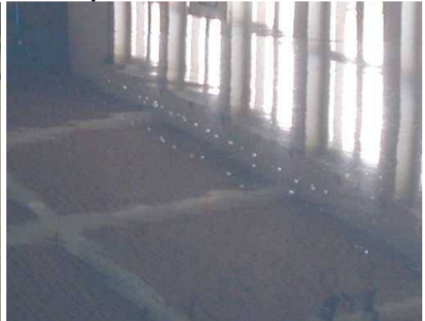
après l'application : bulles au niveau des joints !
