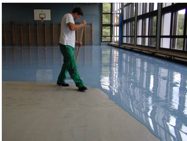
Application de la finition en PUR
