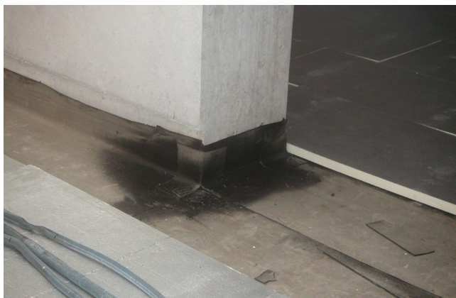
Remonté contre les murs et portes correcte
