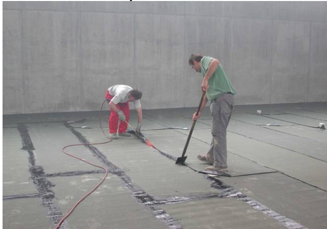
Soudures des lés
