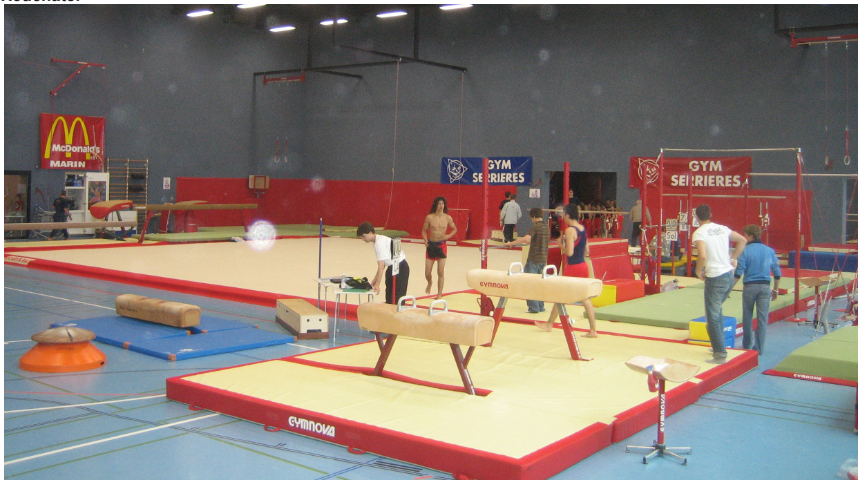
Sol compact à élasticité combinée et chauffage au sol de 2400m 2 ; Construction dans le Stade de la Maladière au dessus des bureaux du Service des Sports !
