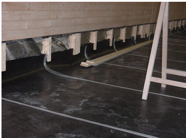
Remonté contre les murs, portes etc.. en pose flottante, par contre, remonté et collage contre les douilles
