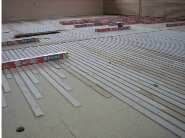
Surface du type compact prêt à recevoir une finition en parquet
