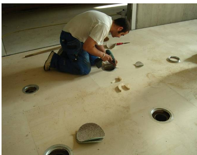
Finition avec un couvercle sans appui sur la douille et étanche à l'eau de nettoyage
