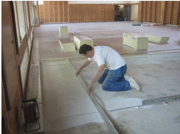
Egalisation du niveau avec des granulés bitumés, sable de quartz ou matériaux similaires
