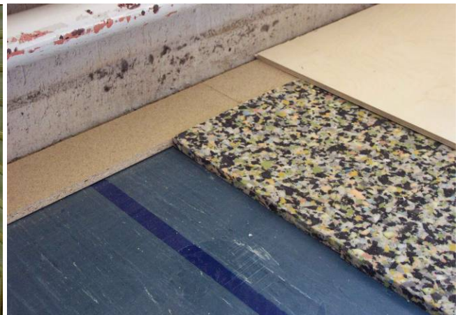
Lors d'une rénovation : pose du sol compact directement sur l'ancien sol sportif
