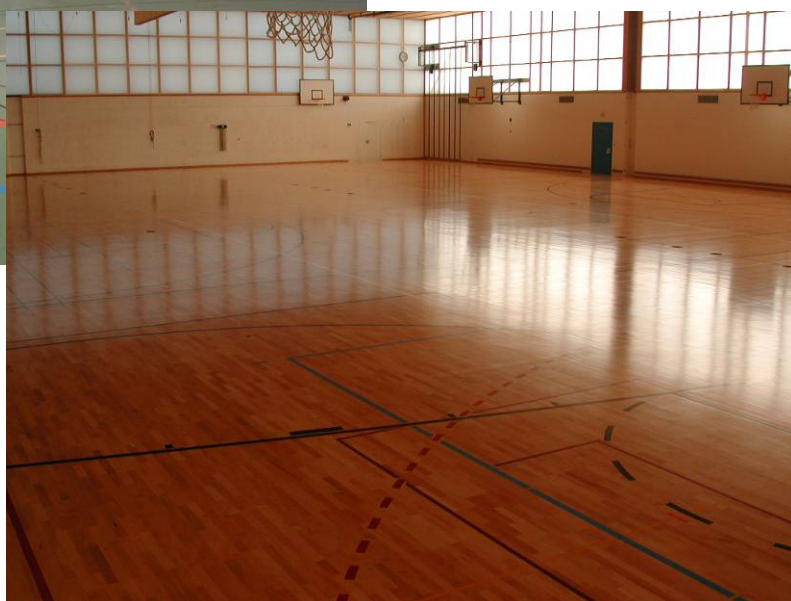
Sol compact à élasticité répartie en parquet, posé directement sur l'ancien sol en polyuréthane
