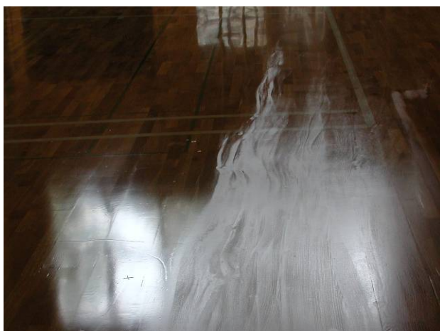
Distribution irrégulière du vernis avec des surépasseurs
