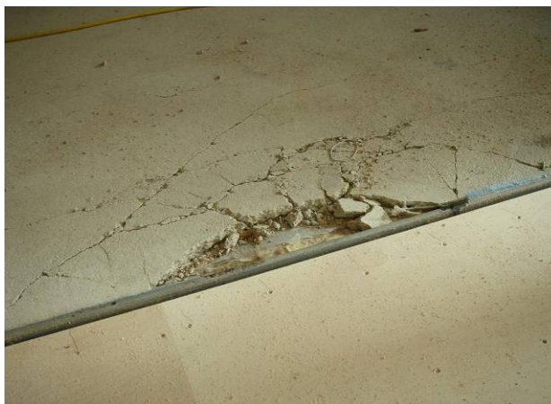
Chape en anhydrite : épaisseur et ponçage insuffisant
