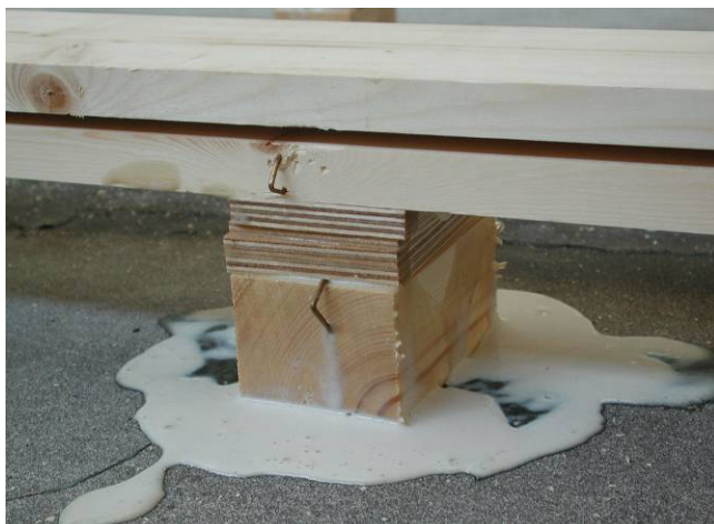
Fixation avec de la colle souple
